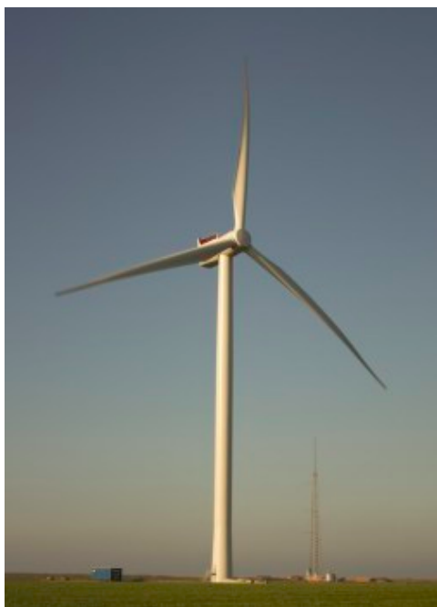
Exemple d'éolienne à axe horizontal
